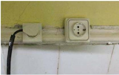
Figura 5. Derivaciones de enchufes sin toma de tierra, con cableado de suministro inadecuado.
