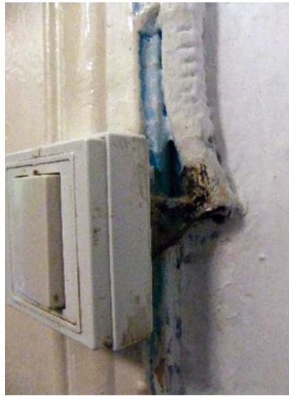
Figura 7. Aislamientos deteriorados.
